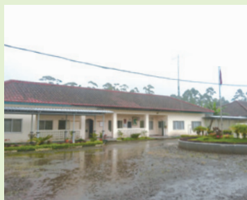
馬鈴薯種子プロジェクトにより設置された馬鈴薯原種センター
