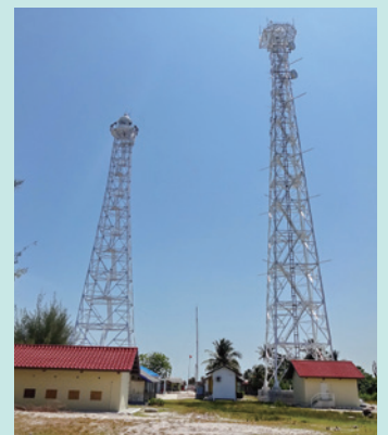
VTSレーダー(タンジュンメダン) (Photo: 日本無線)
