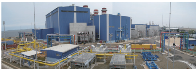
タンジュンプリオク発電所 (Photo: 東電設計株式会社)
