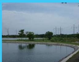
デンパサール汚水処理場 (Photo: JICA 事後評価報告書)
