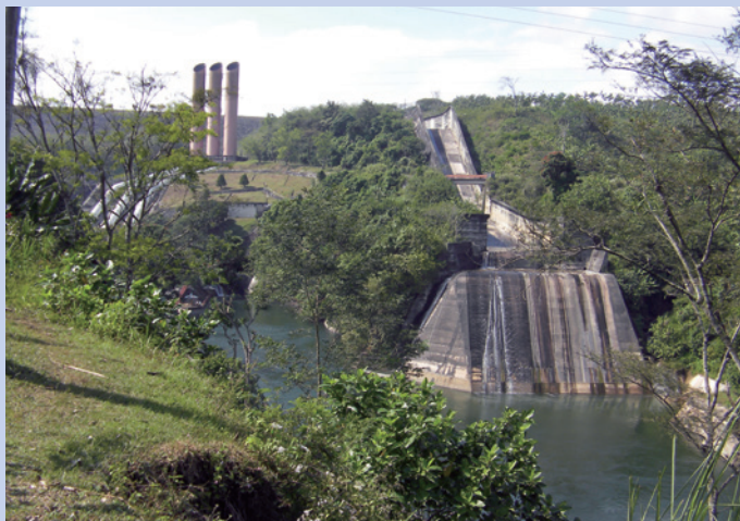
カランカテスダム(下流より上流をのぞむ) (Photo: 日本工営株式会社)
