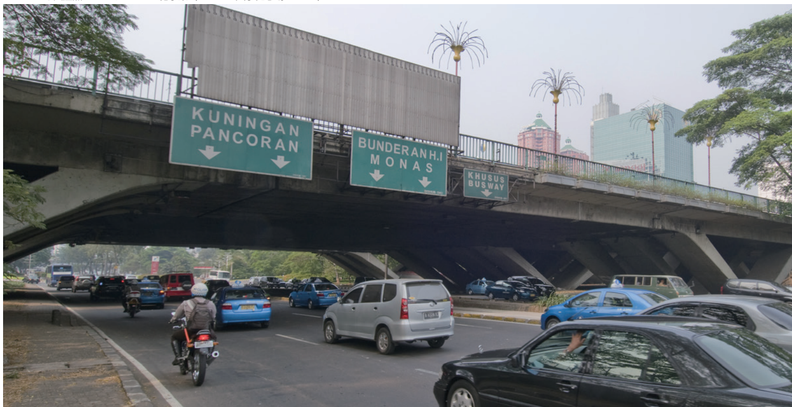
スマンギ交差点のフライオーバー化事業 (Photo: 今村 健志朗 / JICA)
